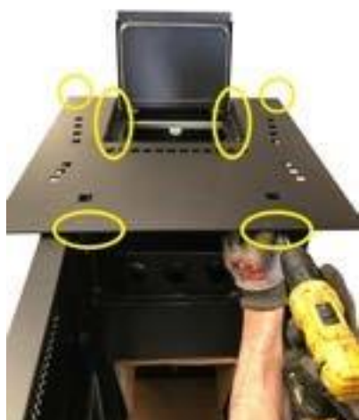
Obrázok 34 – Odstráňte skrutky
