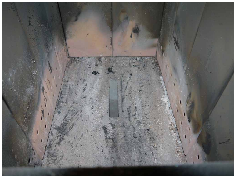
Obr. 6 Správne vyčistená nakladacia komora
